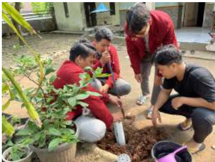
Gambar 4. Proses Pemasangan Lubang Biopori
